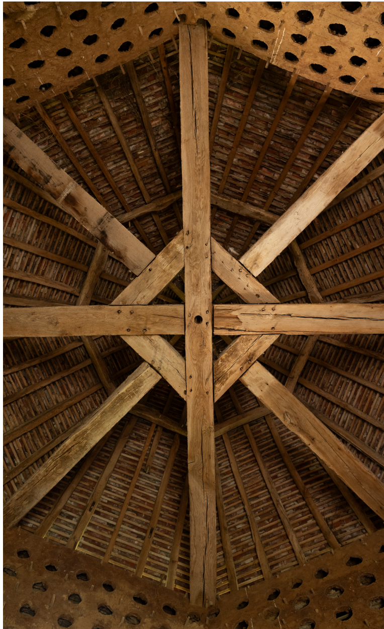
Vue intérieure de la charpente du pigeonnier.
