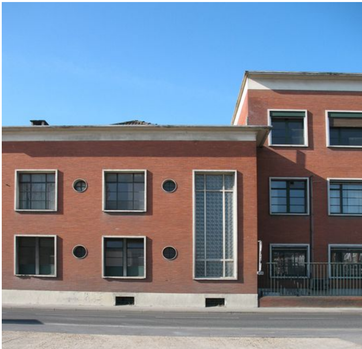
Détail de la façade des bureaux.
