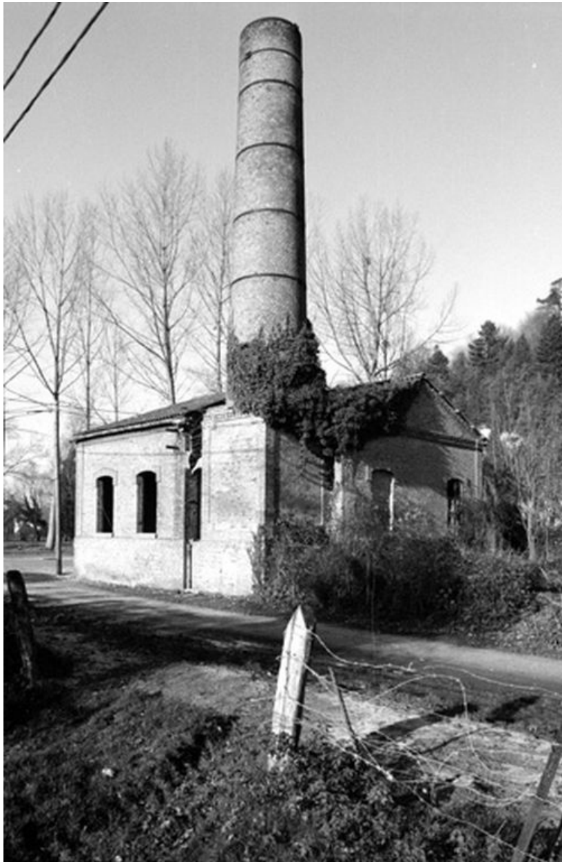
Chaufferie, cheminée d'usine. Salle des machines, rue du 19e BCP.
