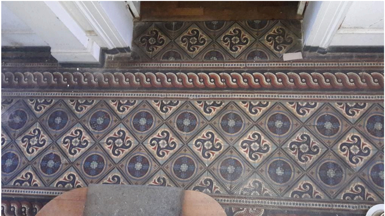
Ferme des berceaux : détail du sol en carreaux de ciment du couloir traversant de la maison de maître en 2017. (Coll. part.)
