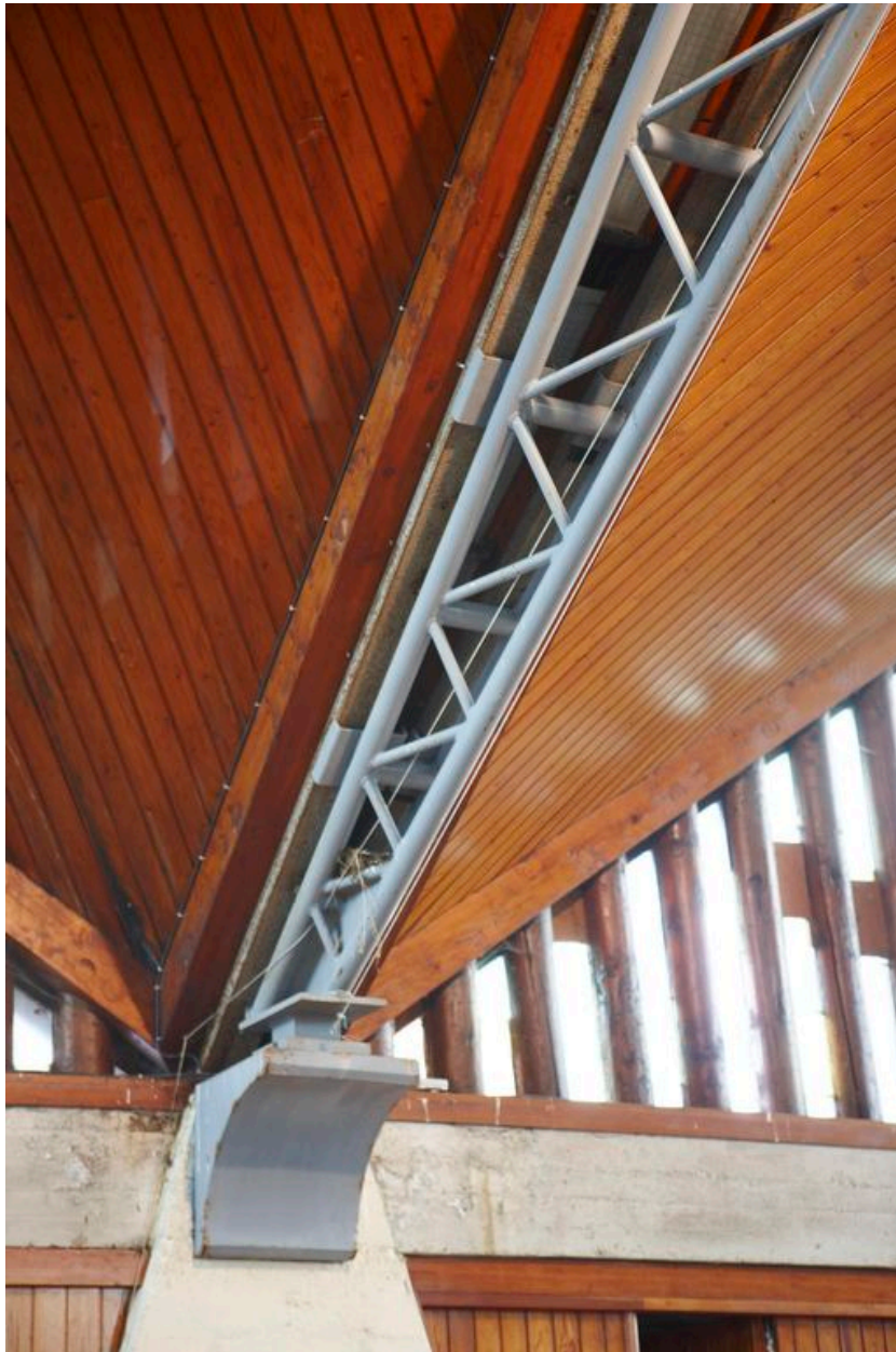
Intérieur, détail : départ d'une ferme métallique, couverture lambrissé.
