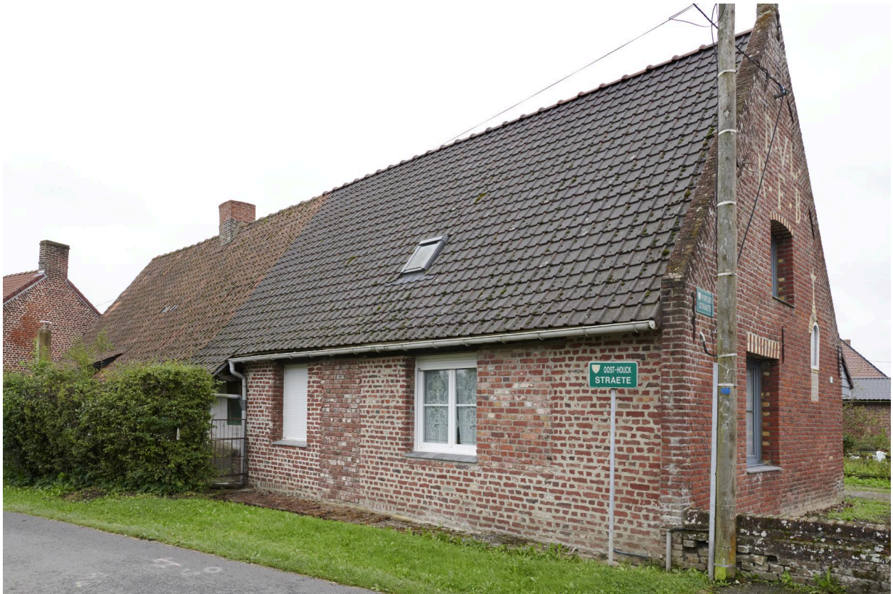
Détail de la façade nord, sur rue.
