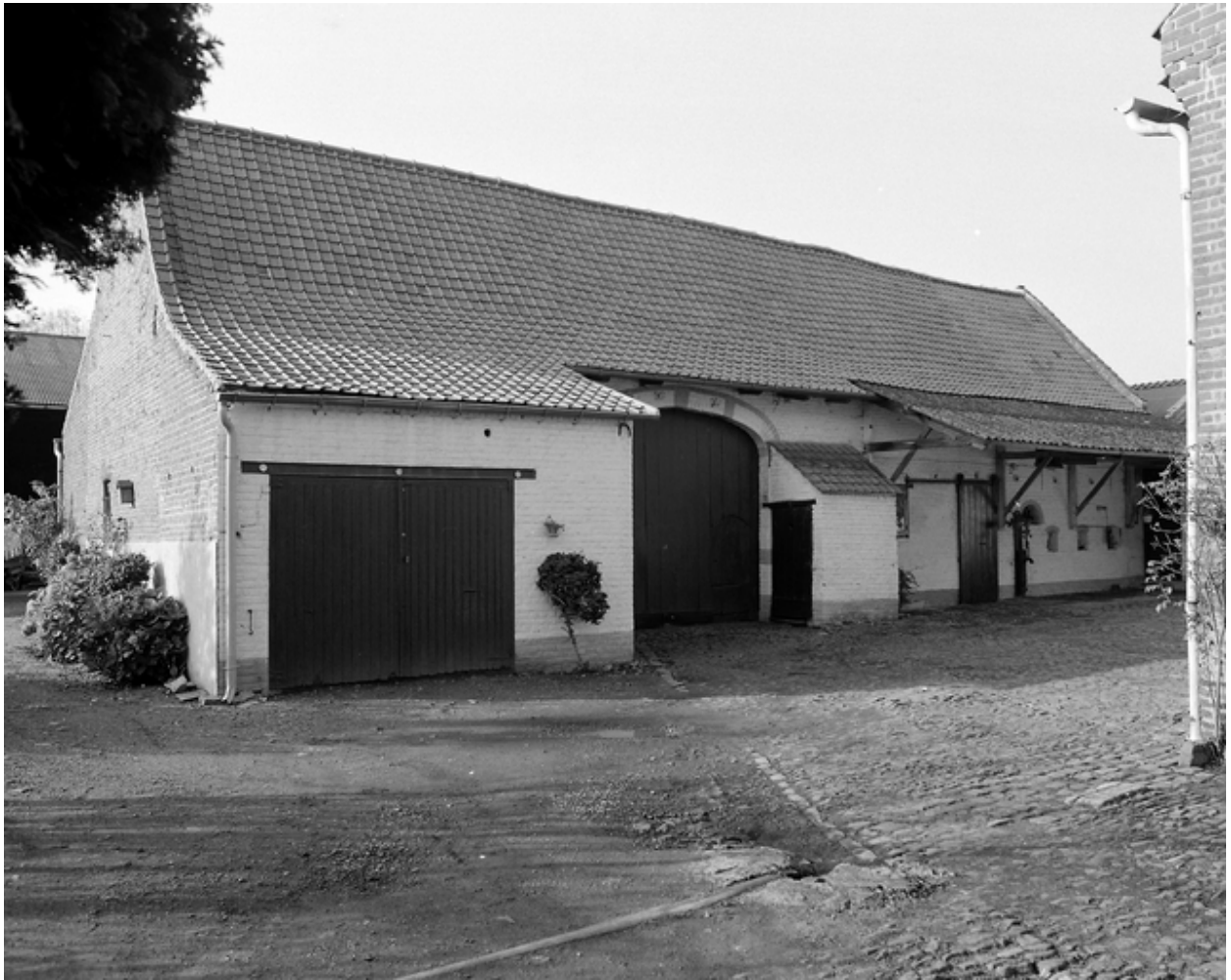
Ferme, 160, rue du Presbytère, la grange.
