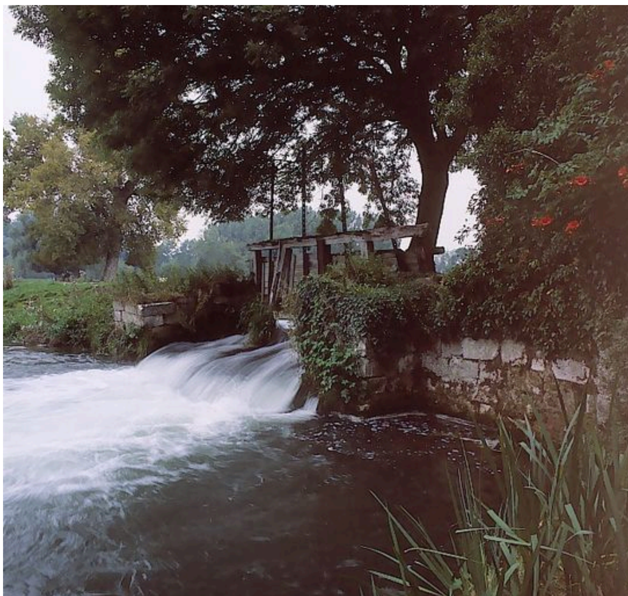
Les vannes de décharge.
