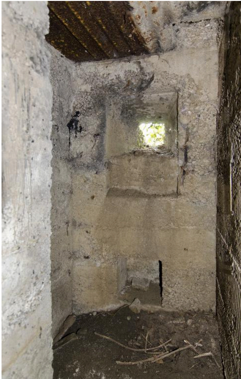
Créneau de fusillade vers le sud-ouest
