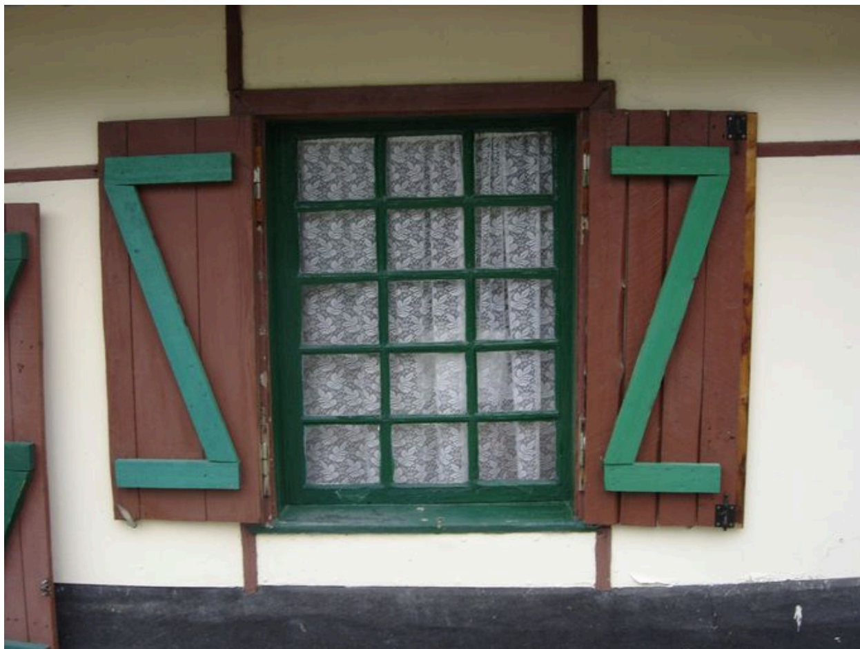
Vue d'une baie à quinze carreaux.
