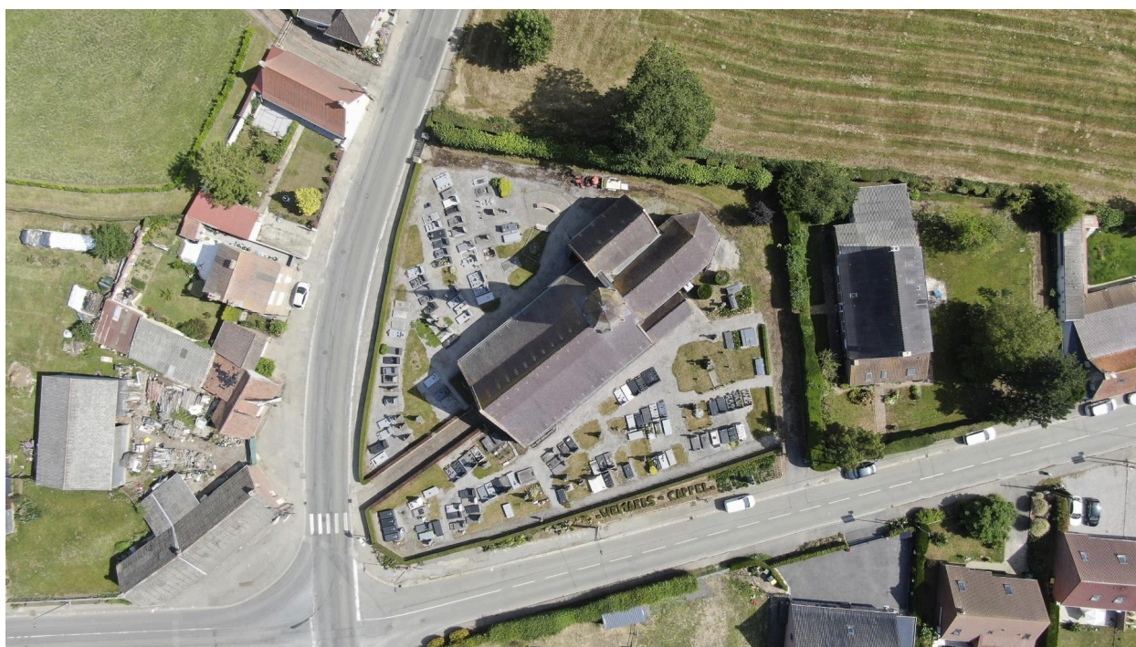
Vue zénithale de l'église.
