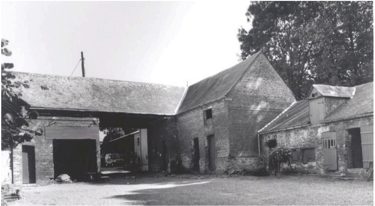
Vue d'ensemble de l'entrée charretière et des dépendances agricoles.
