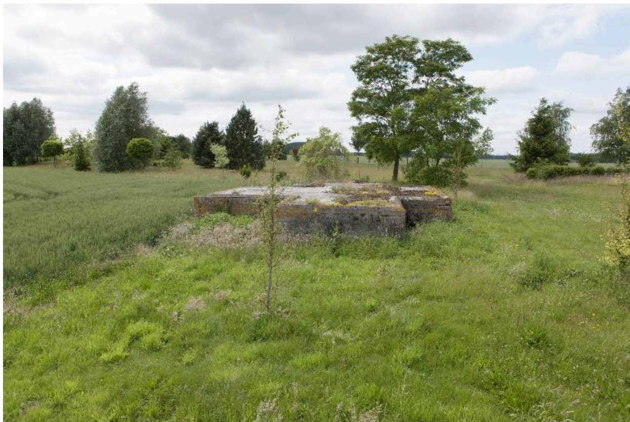
Vue latérale, vers le nord-ouest, de la casemate ouest
