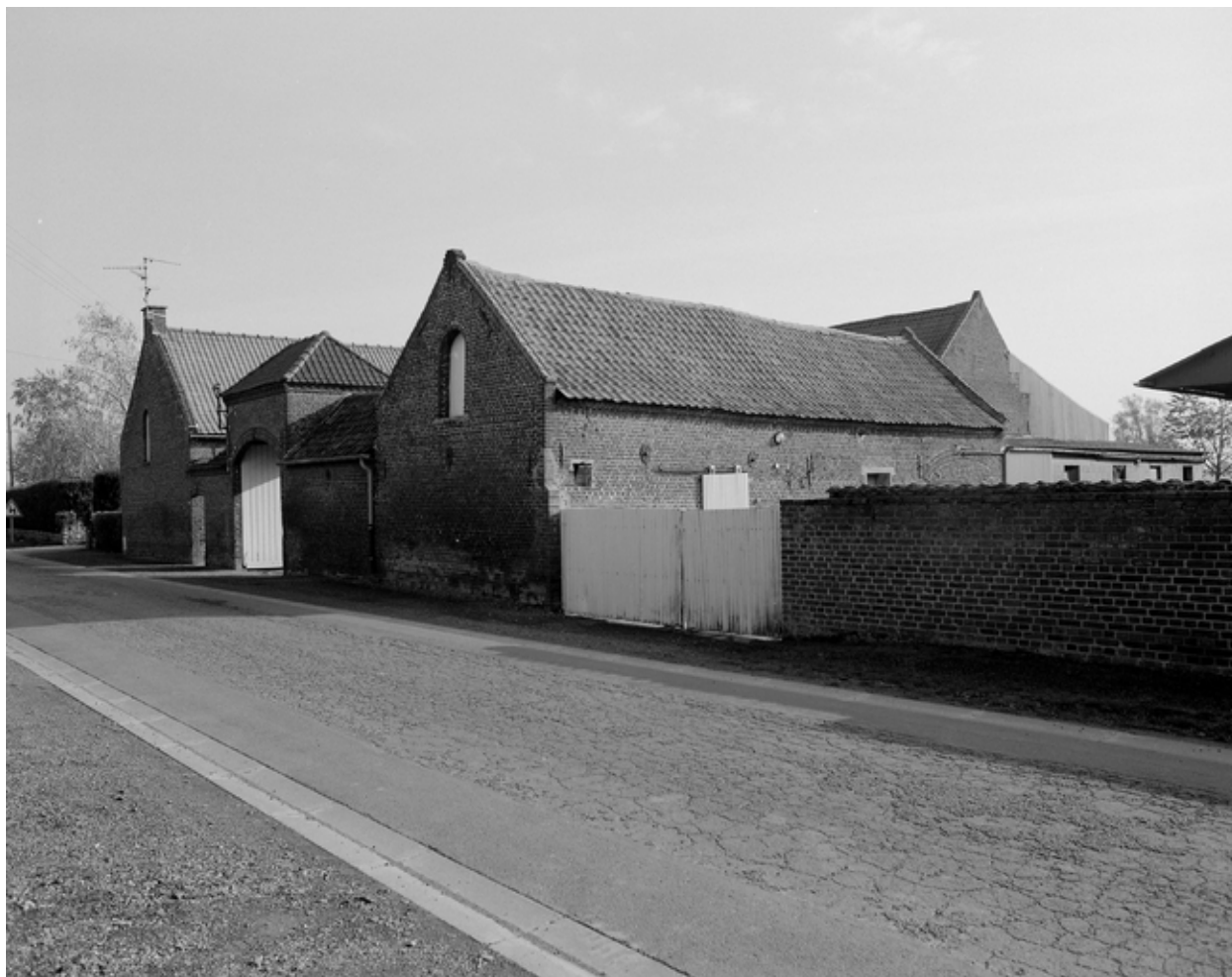
Ferme, 344, rue de Balory, vue générale.
