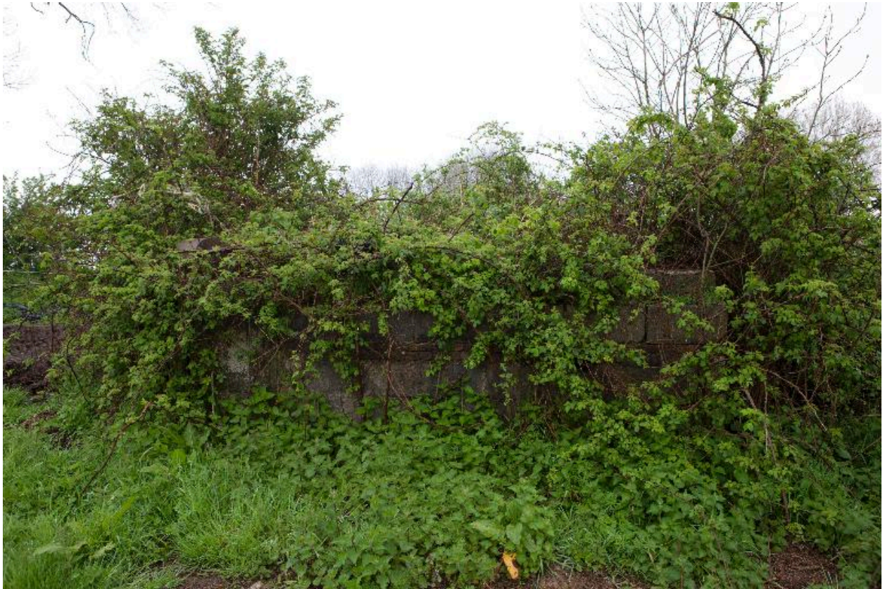
Bunker de tir.
