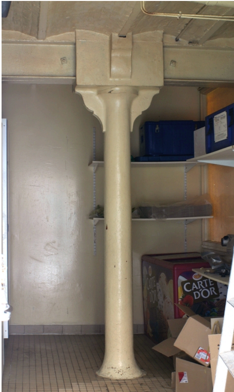
Colonne de fonte, au rez-de-chaussée du bâtiment sur cour.
