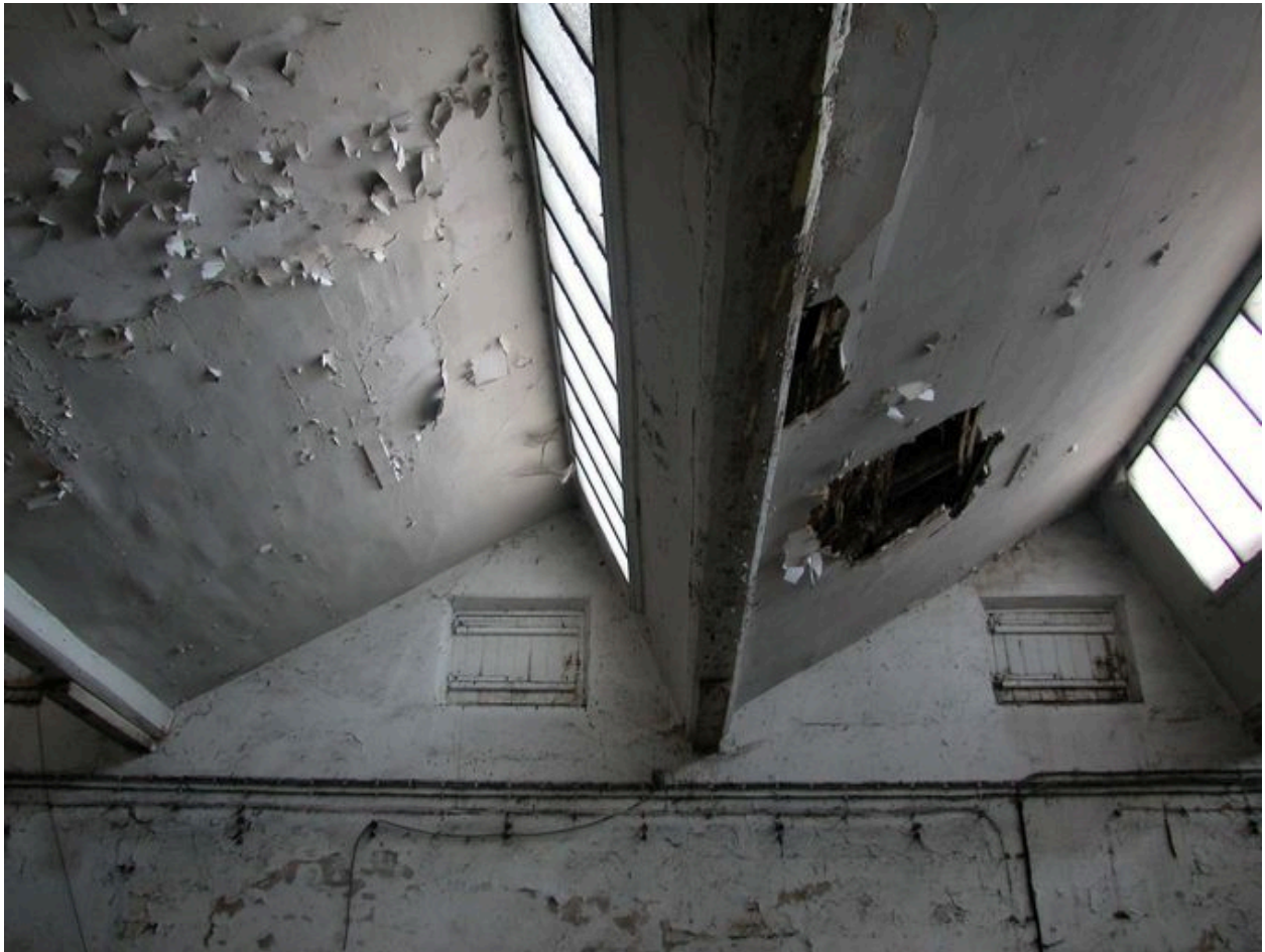
Vue intérieure des sheds des ateliers.
