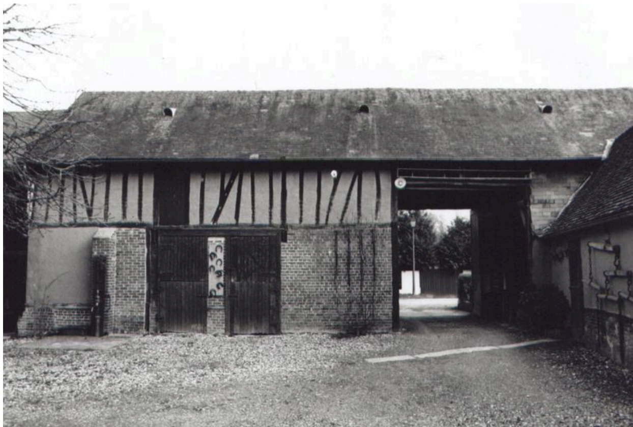
Les grange et l'entrée charretière sous porche, façade sur cour.
