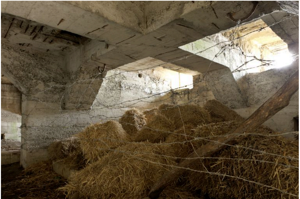
Salle principale, vue du couvrement en béton armé
