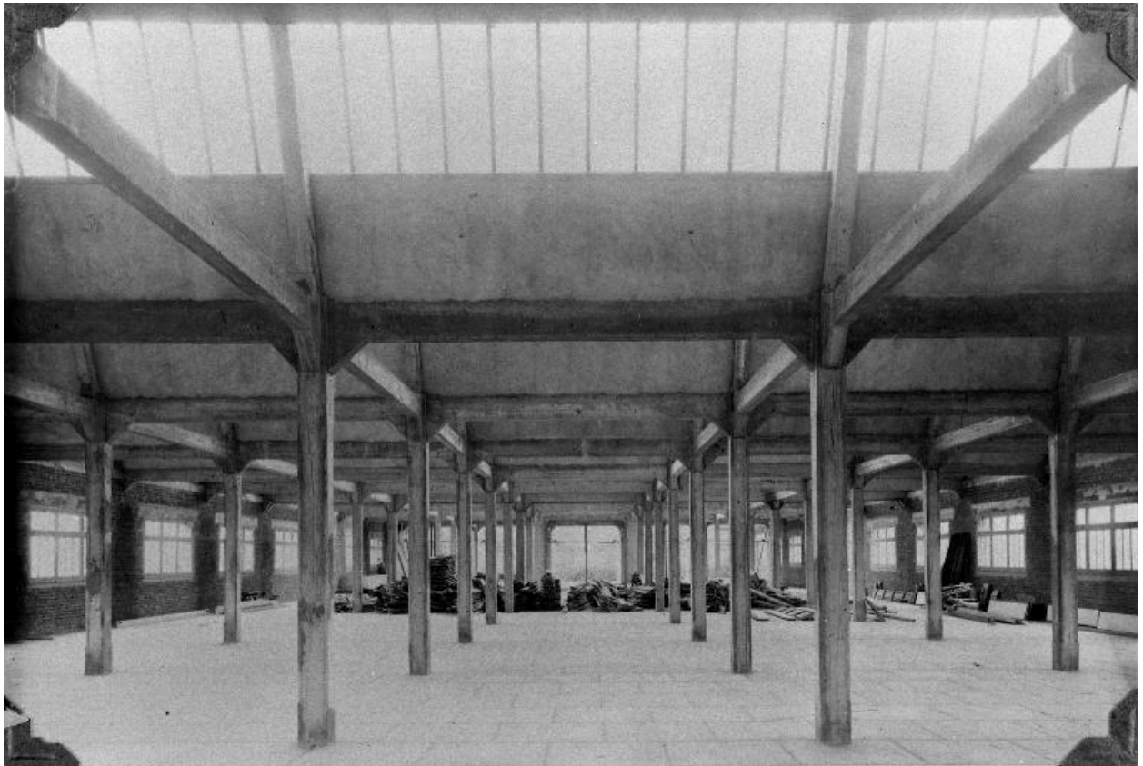
Intérieur de l'atelier de fabrication, dit atelier n°2, vue vers le sud, avant la mise en place des machines, mars 1947 (archives privées de l'entreprise).
