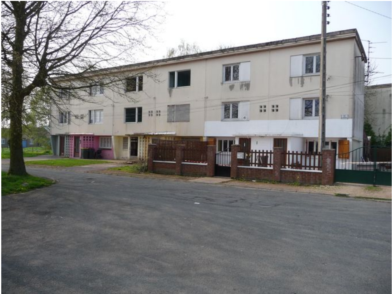
Vue générale d'un groupe de six logements.
