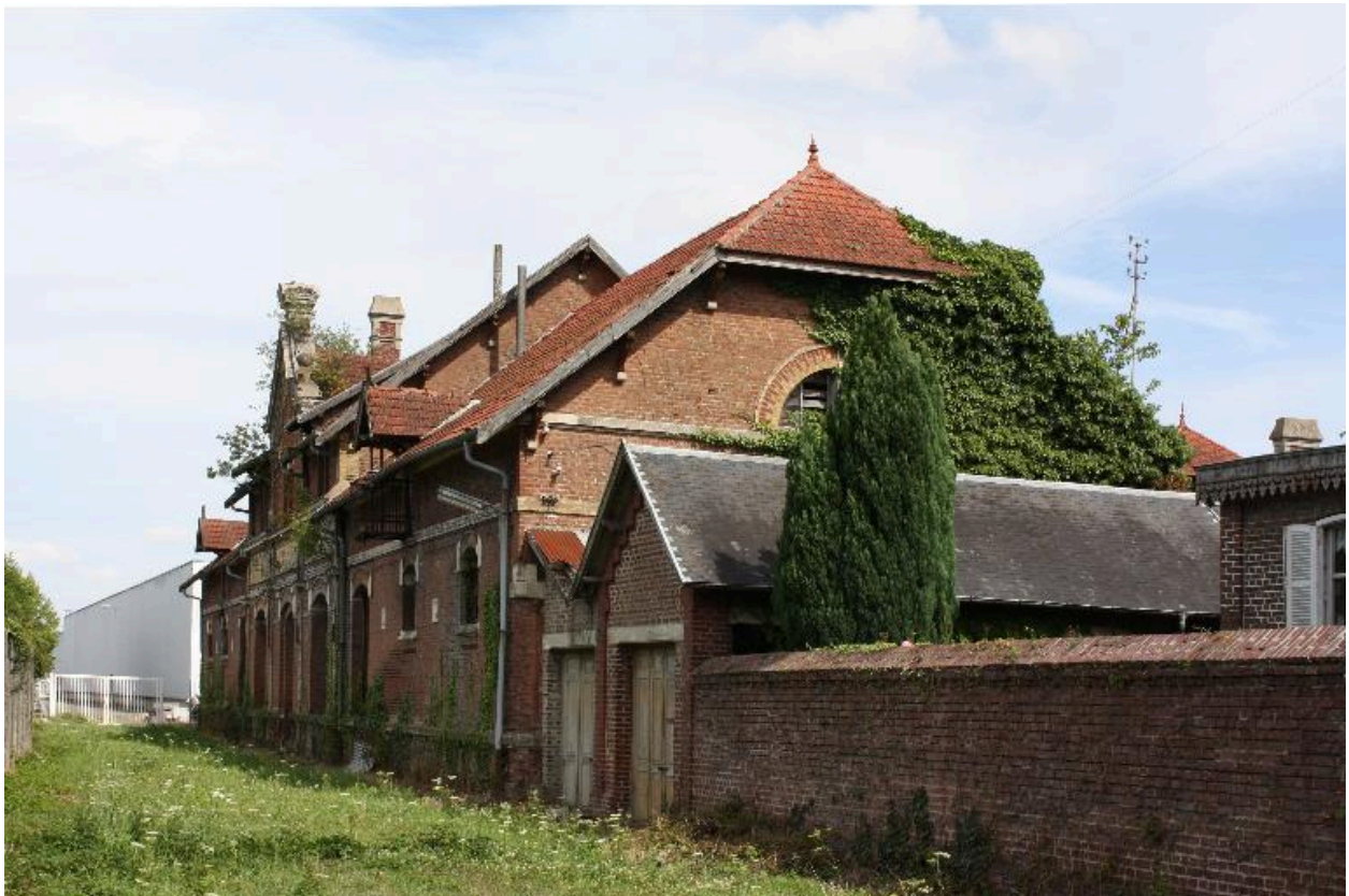
Vue du magasin coopératif depuis le tracé de l'ancienne voie ferrée.
