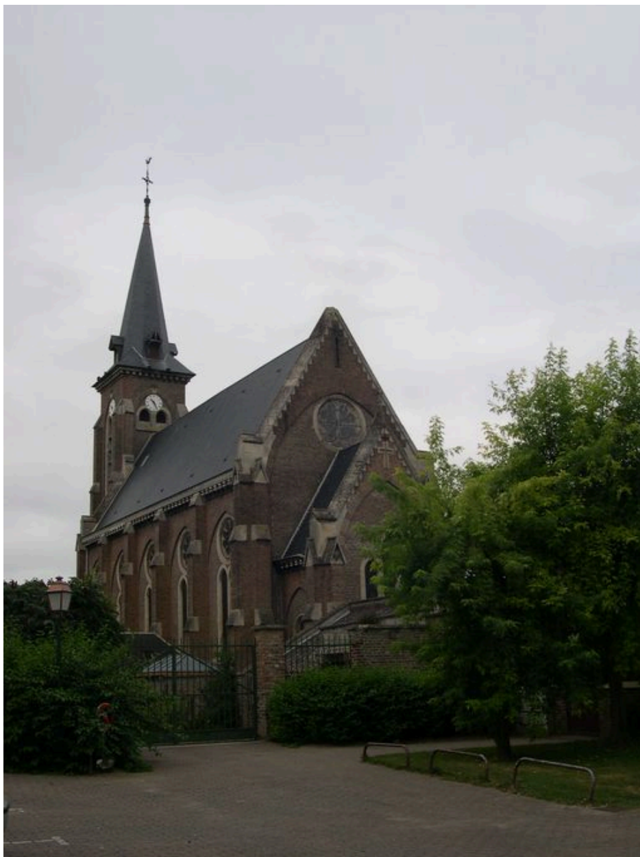
Vue depuis le sud-est.
