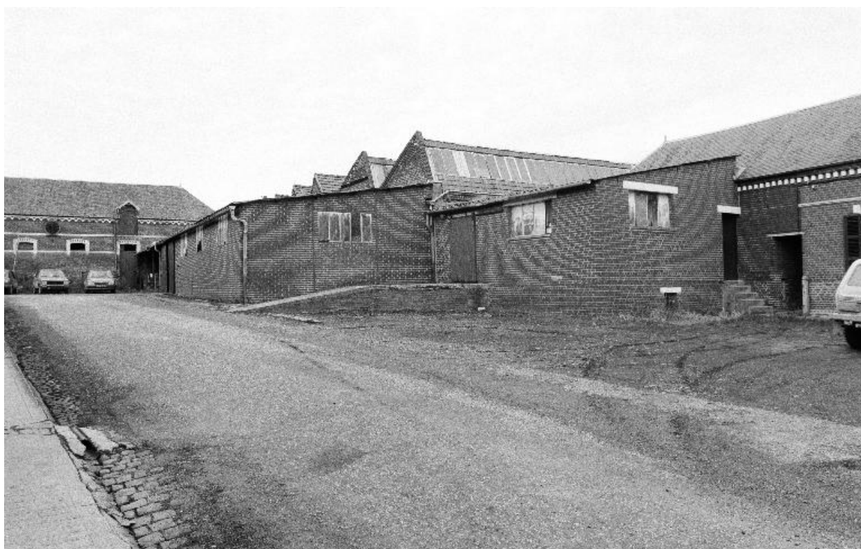
Magasin industriel. Élévation antérieure.
