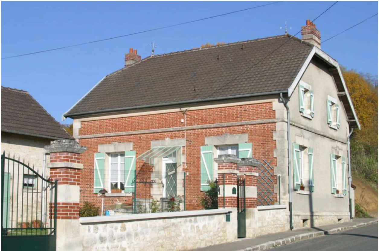
Vue générale de la façade principale.
