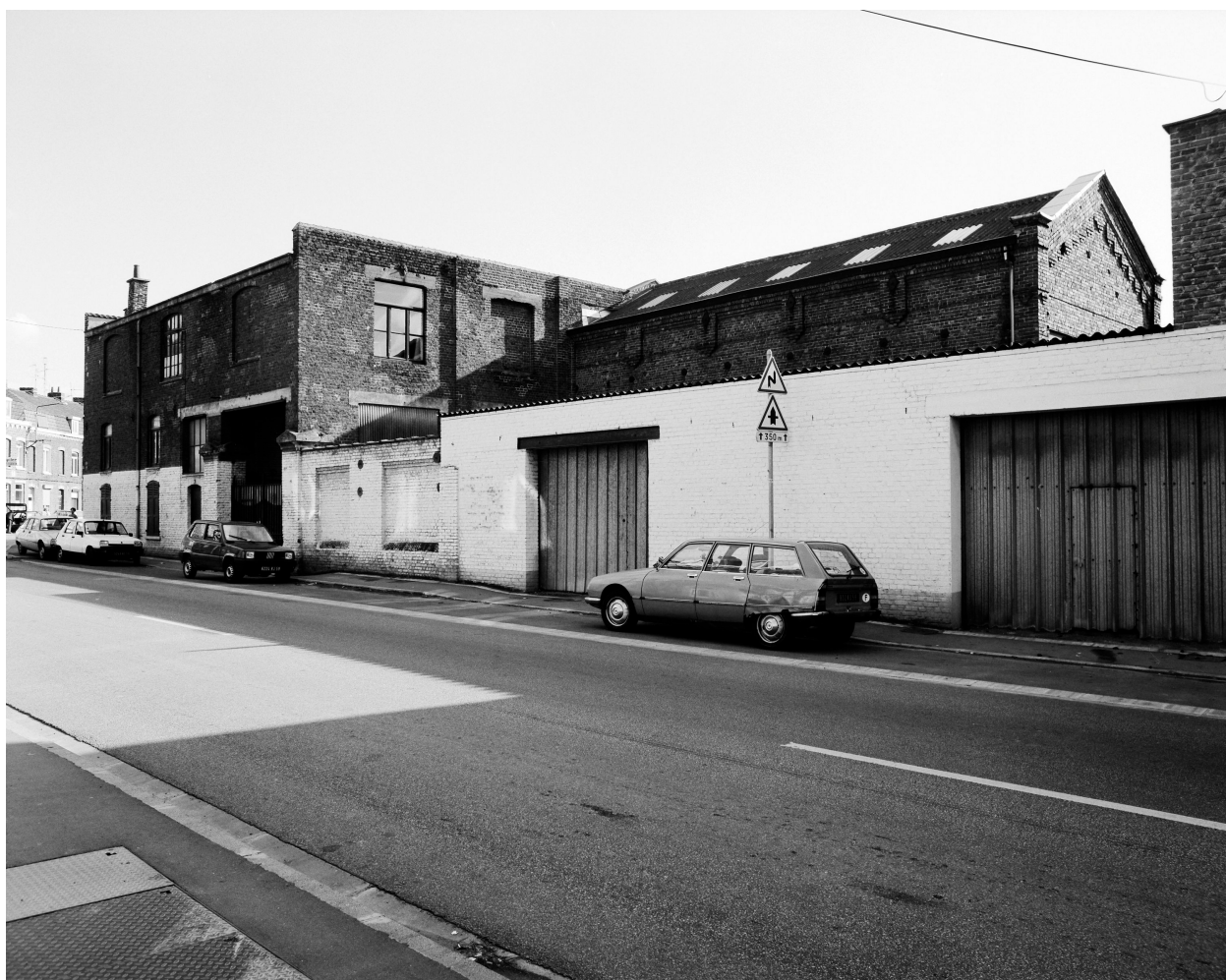
Atelier de fabrication, élévation rue Roger-Salengro.
