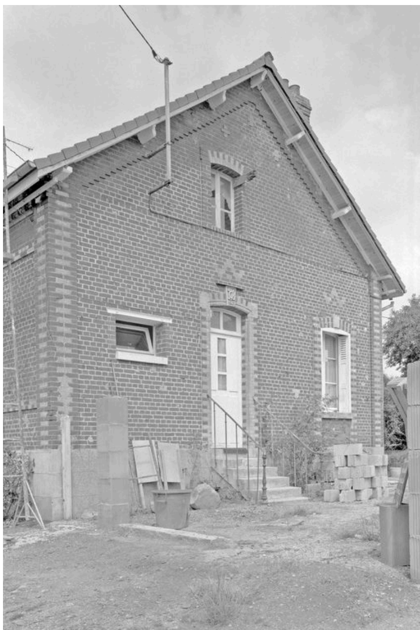
Maison repérée datée 1907. Détail du pignon.
