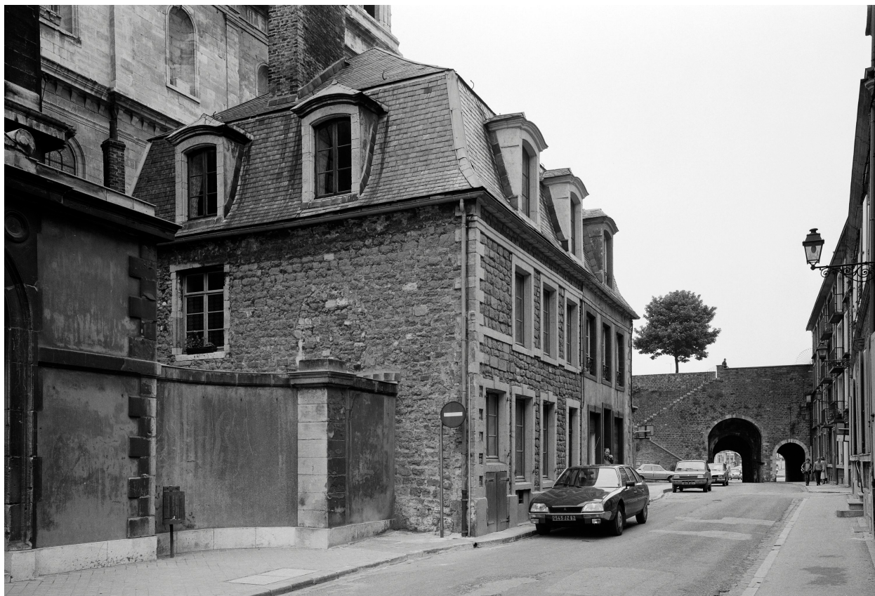
Vue d'angle sud-ouest.
