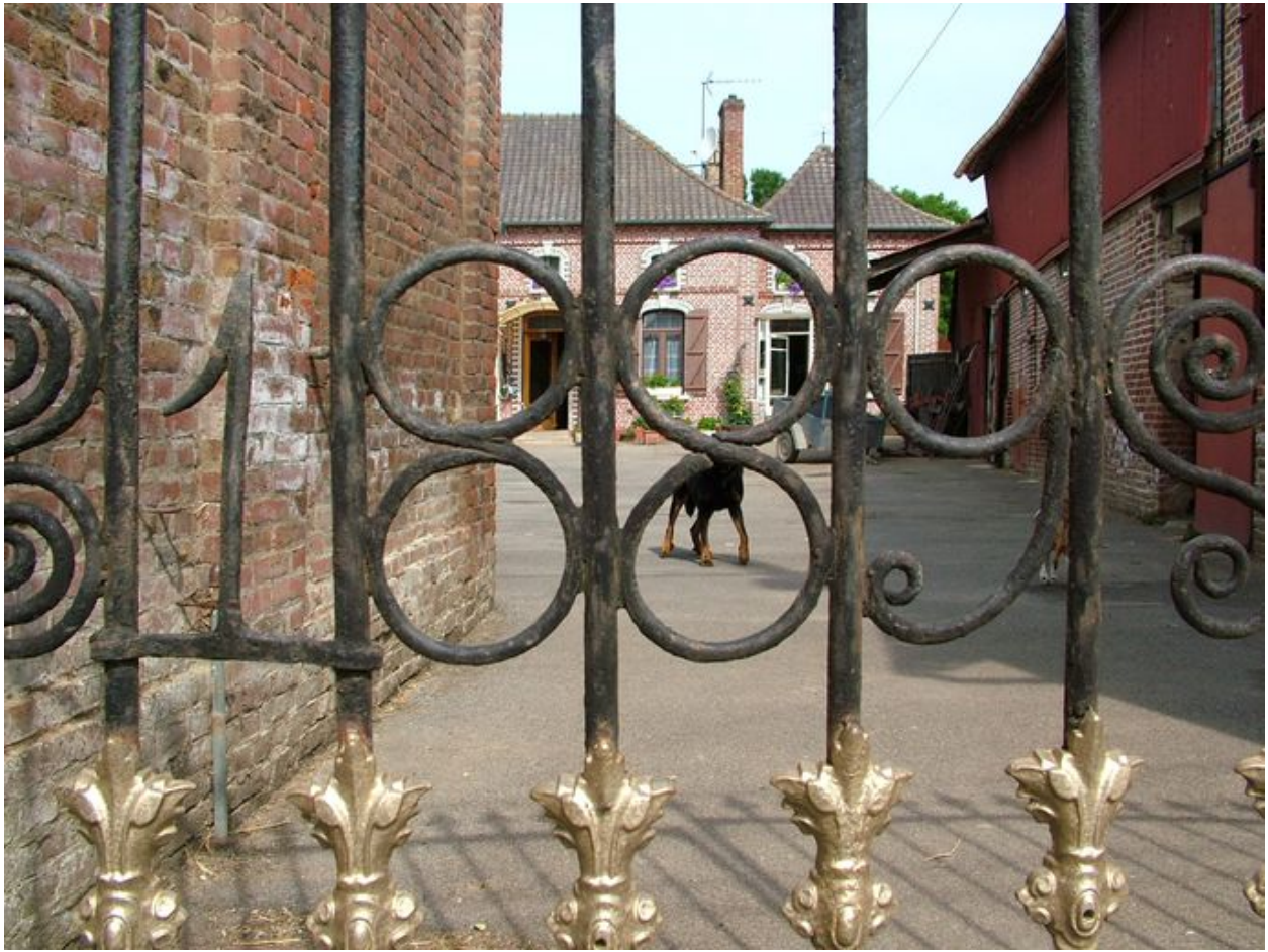
Détail du vantail gauche de la grille datée : 1889.
