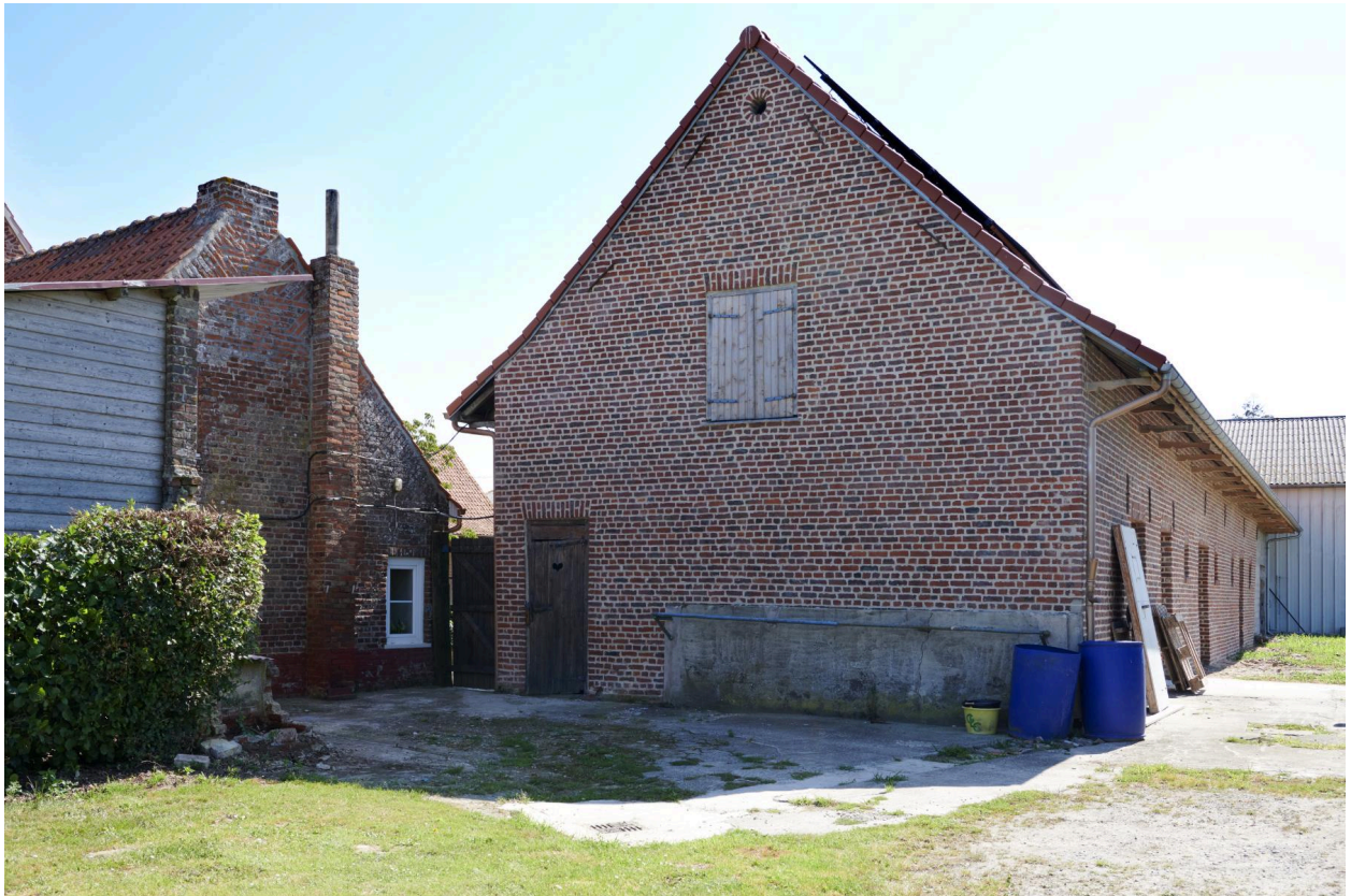
Détail du pignon du bâtiment agricole au sud.
