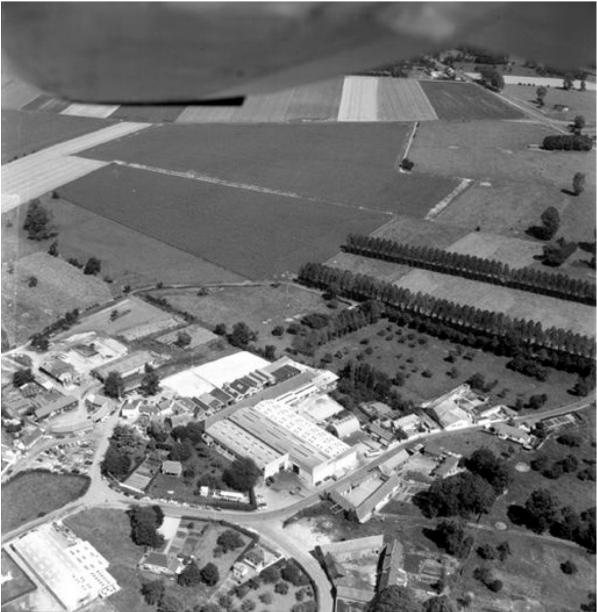
Vue aérienne de l'usine et du hameau de Saucourt depuis le nord, en 1990.
