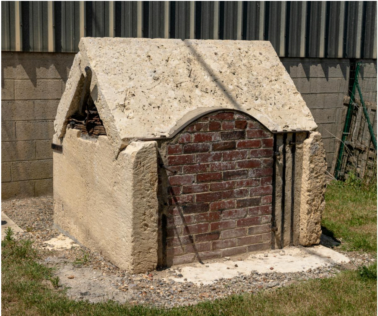
Ancien puits rue Notre-Dame, vue depuis le sud-est.
