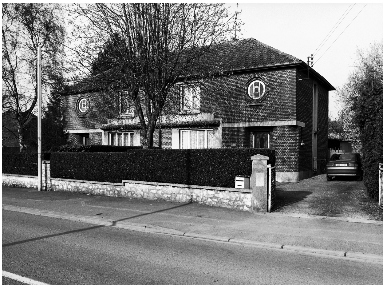
Vue générale du module (35-33 rue Anatole-France).
