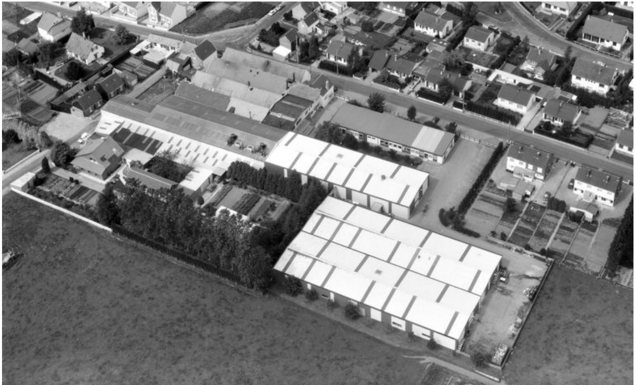
Vue aérienne, flanc sud.
