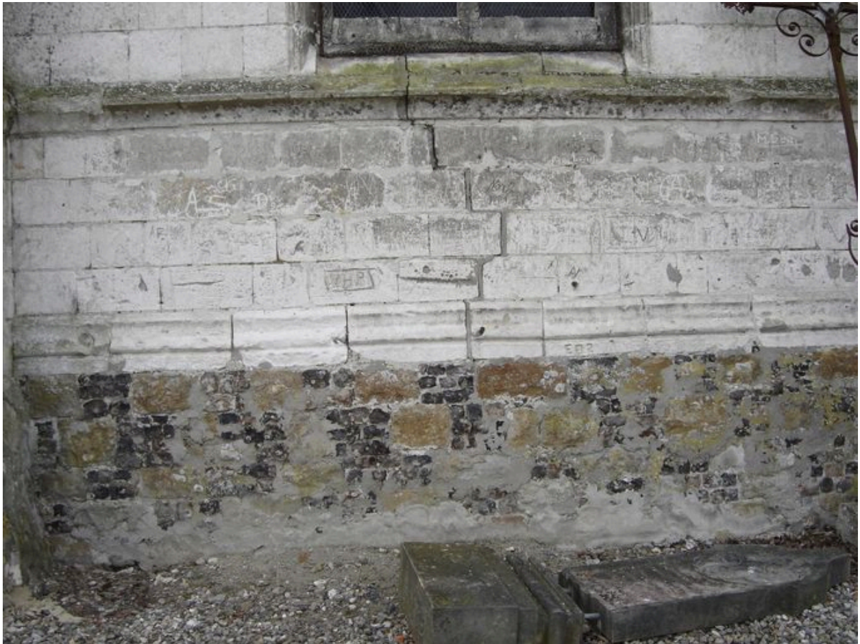
Vue sur le soubassement du choeur.
