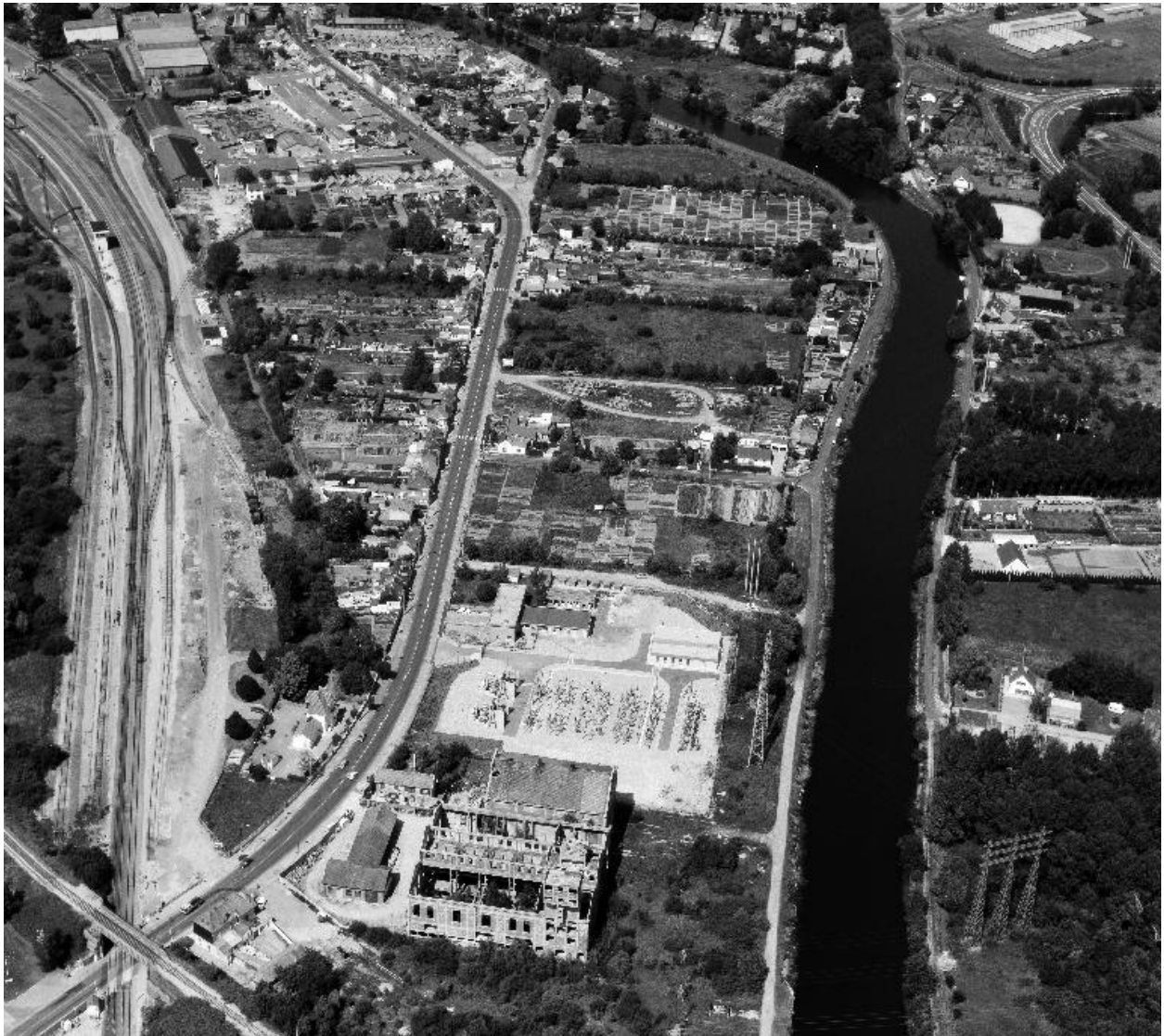
Vue aérienne de 1990, flanc sud.
