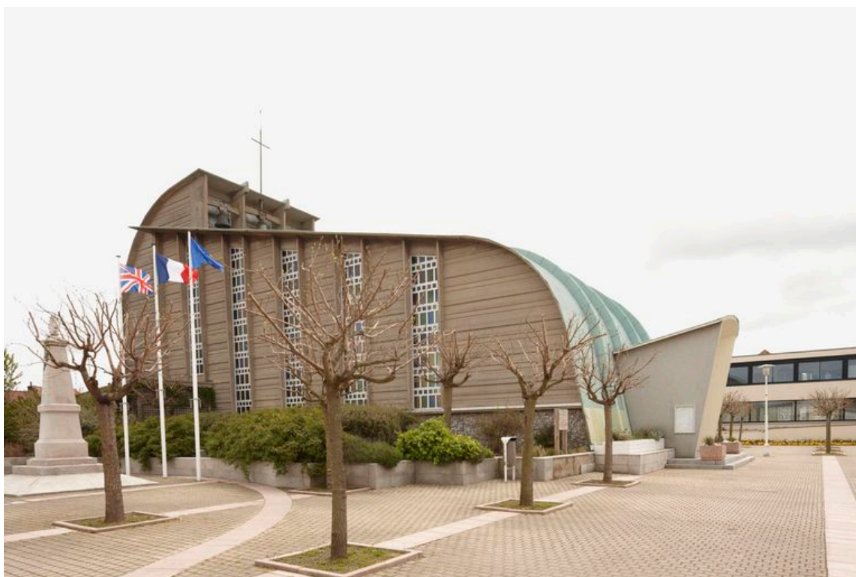
Vue générale de l'élévation latérale.
