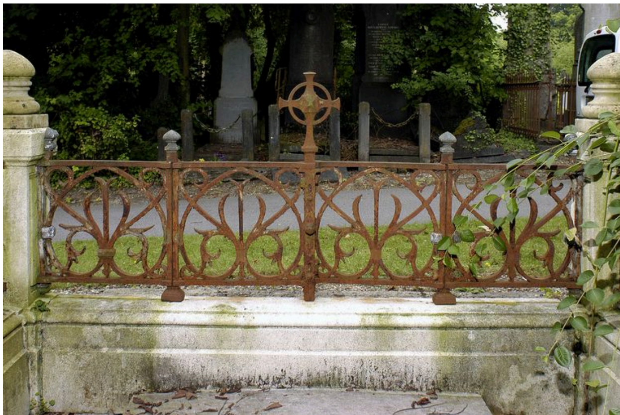
Détail de la clôture.
