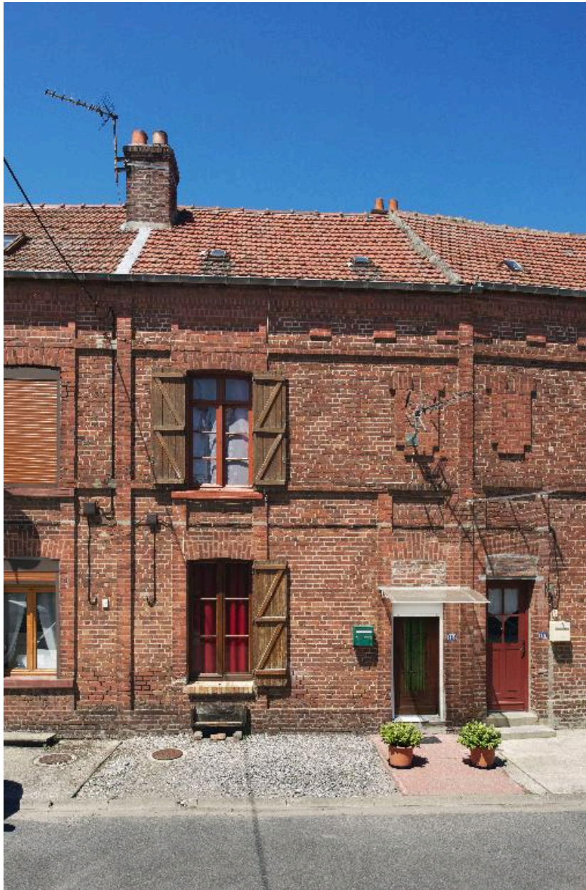
Détail du logement n°13 de l'impasse Gabriel-Péri.
