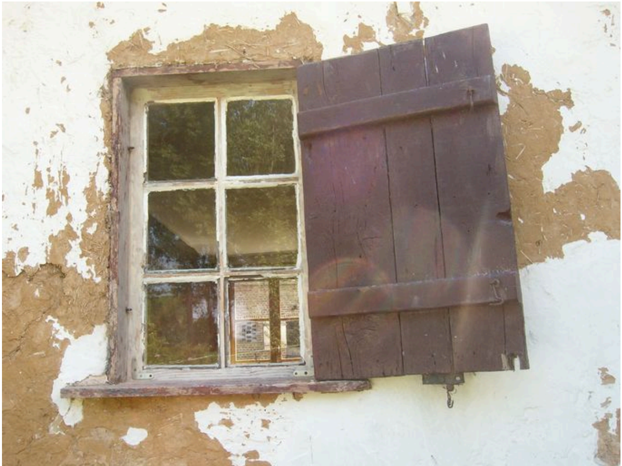
Détail d'une fenêtre sur le mur gouttereau postérieur.
