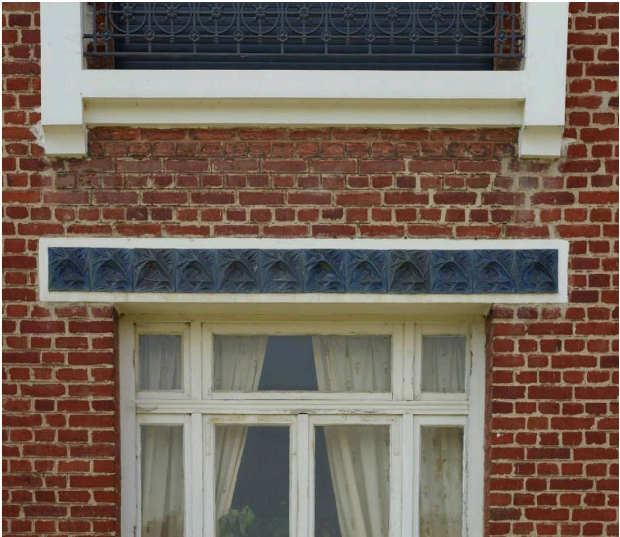
Maison, n° 17 rue du faubourg de Péronne. Détail des bandeaux de grés émaillés à décor de feuilles de chardon des linteaux, de la maison Emile Muller de Nancy.
