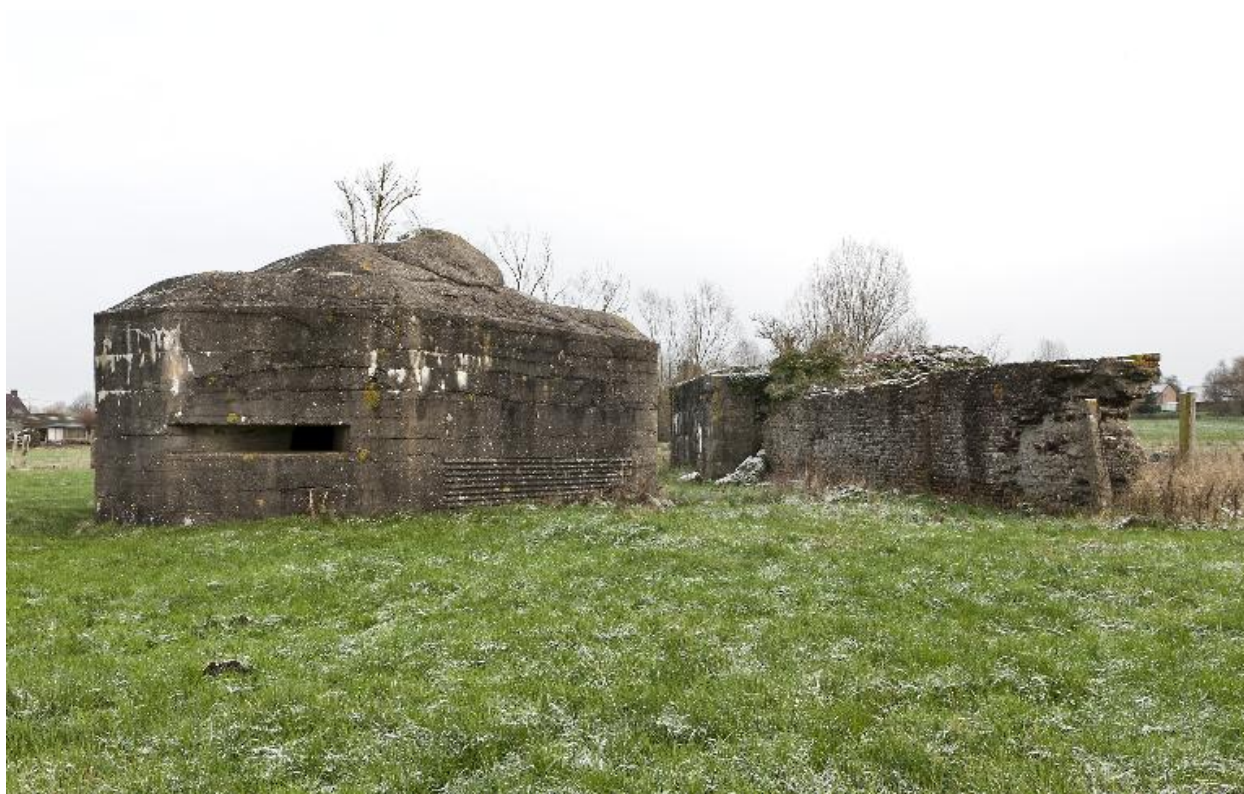
Vue vers le sud-est
