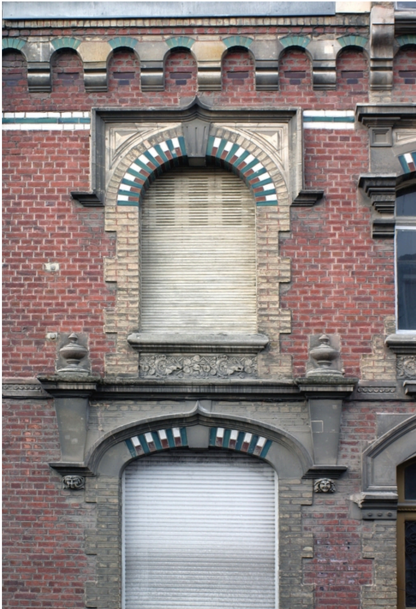
Façade, 2 rue du Général Foy : détail.
