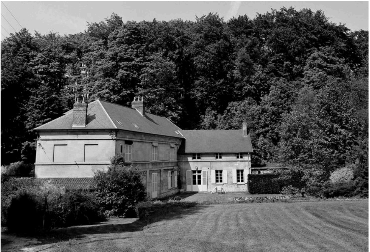
Logement patronal, angle sud-est.
