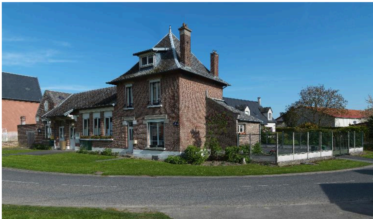
Vue générale, depuis le nord-est. La clôture délimitait le jardin de l'instituteur.
