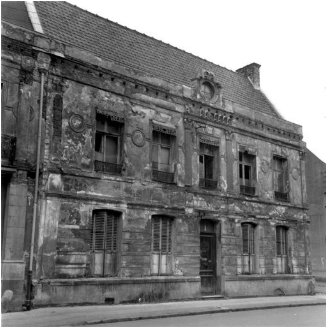
Façade rue Notre-Dame : vue générale (état en 1981) (Médiathèque du patrimoine).
