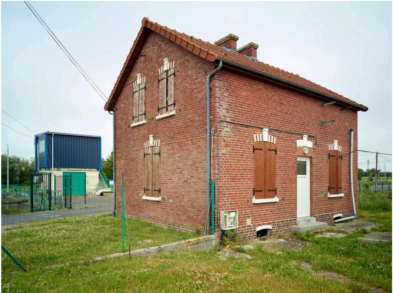
La maison de service (aval).
