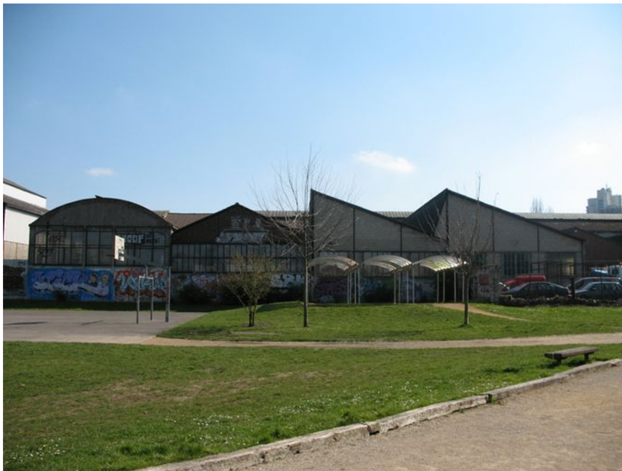
Vue des bâtiments depuis le nord.
