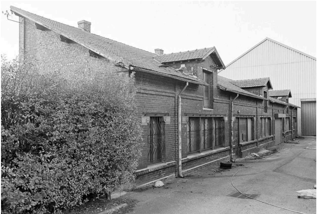
Remise, ateliers de fabrication secondaires.
