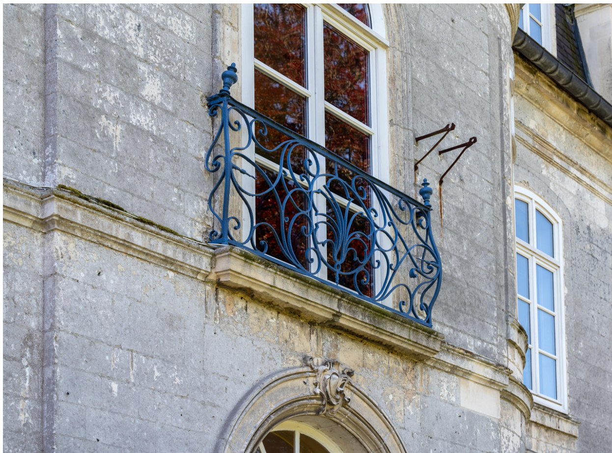
Façade nord donnant sur le jardin d'agrément. Détail du du garde-corps en ferronnerie au second niveau du grand avant-corps central.
